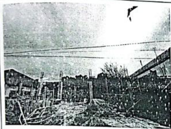
Kondisi Pembangunan Gedung FKG
