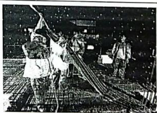
Pengecoran Plat Lantai
