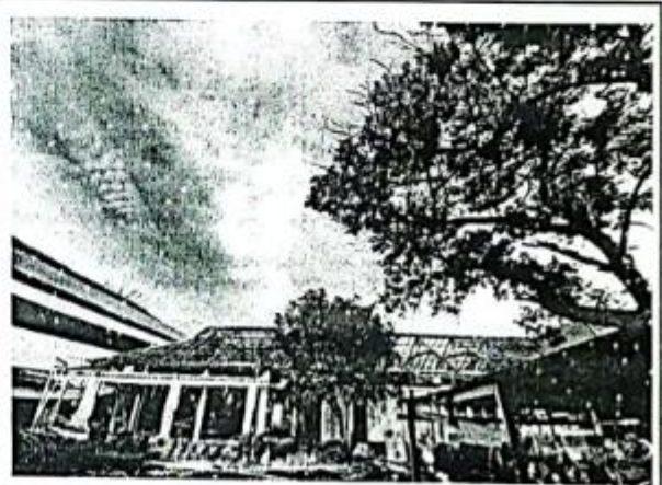
Lokasi Rencana Pembangunan Gedung FKG
