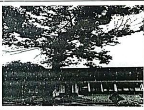
Lokasi Rencana Pembangunan Gedung FKG
